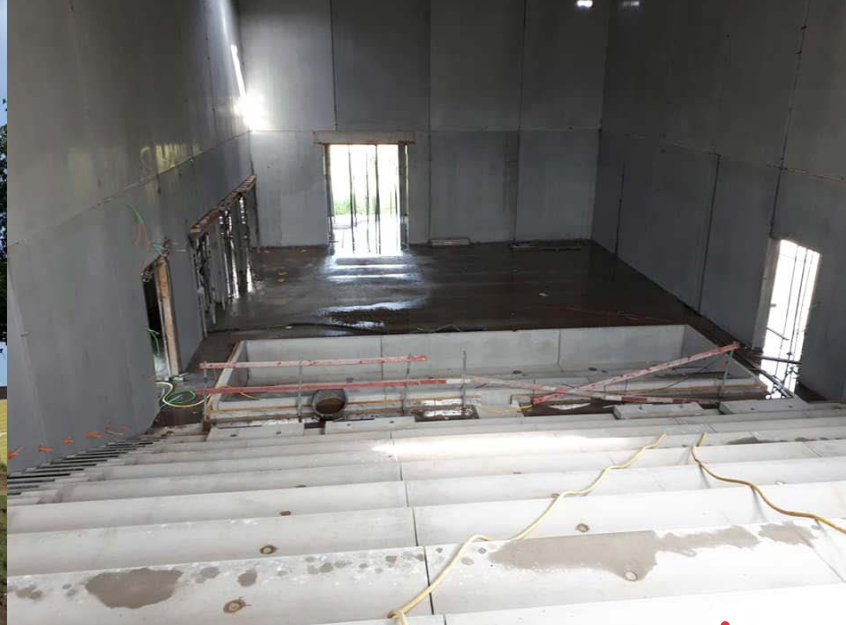
Het nieuwe gemeenschapscentrum in Geluwe is volop in opbouw. De werken vorderen goed en stilaan zien we de definitieve contouren van de gebouwen.
